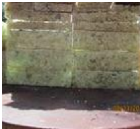
Imagen 37, Prueba de exposición abierta a la luz solar simulando la fachada de una edificación
