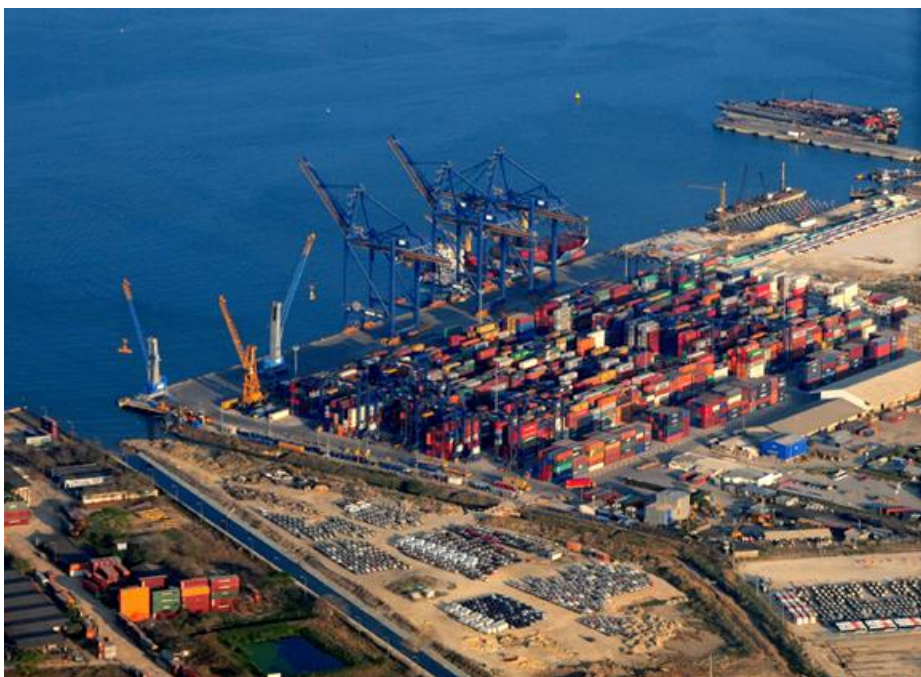
Figura 5. Terminal de Contenedores de Cartagena S.A. - CONTECAR S.A.
