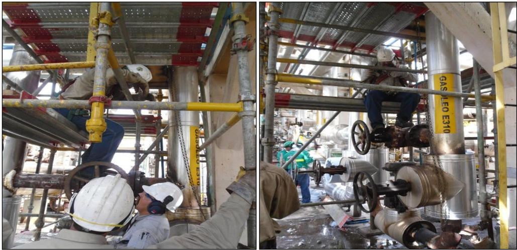
Figura 22: Supervisor de Campo, HSEQ y operario coordinando como realizar la maniobra de desmontaje, mantenimiento correctivo y montaje de 01 Válvula de Compuerta 4x600.
