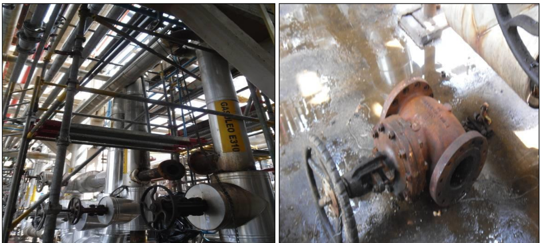
Figura 22: Supervisor de Campo, HSEQ y operario coordinando como realizar la maniobra de desmontaje, mantenimiento correctivo y montaje de 01 Válvula de Compuerta 4x600.
