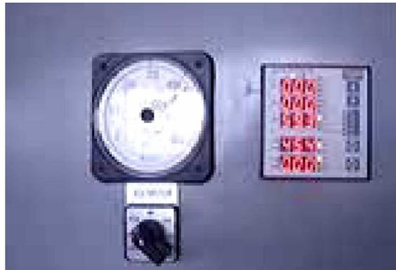
Un interruptor selector de voltímetro es suministrado para seleccionar lecturas en el voltímetro de fase a fase o fase a tierra. Todos los voltajes de línea deben estar iguales para asegurar igual corriente en todas las ramas e igual desarrollo del motor.
