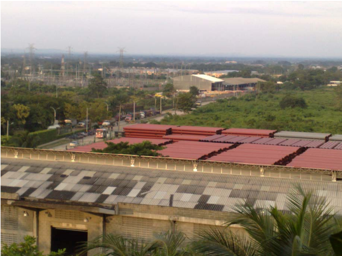
Figura 3. El centro de producción adquirió un área de aproximadamente 30 hectáreas para sus plantas, el cual también ha ido ocupando con lugares para embalaje de tubería.
