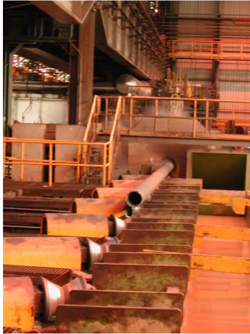
Figura 9. Tubo saliendo de la etapa de quenching.
