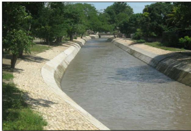
Ilustración 11: Arroyo Grande de Corozal. Zona Rehabilitada
