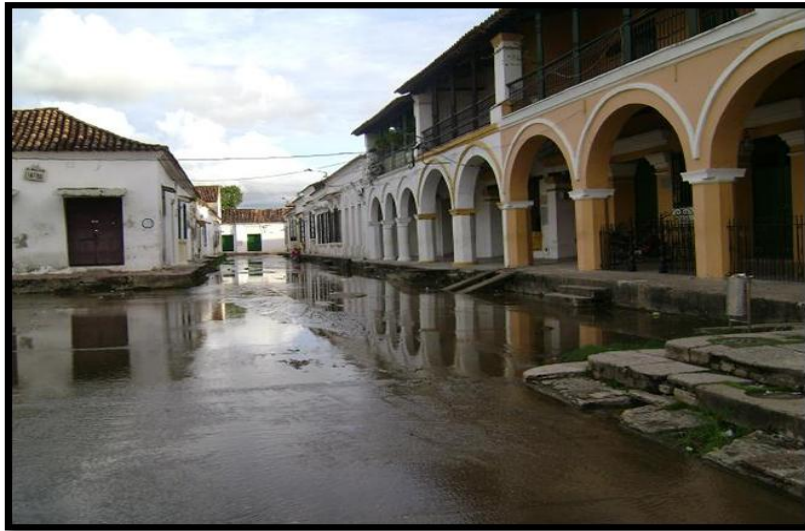
Figura 2. Ciudad De Mompox afectada por las lluvias 8
