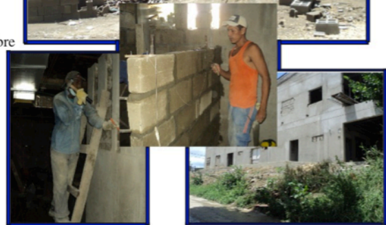
Reconstrucción del Centro de Atención Primaria (CAP)
