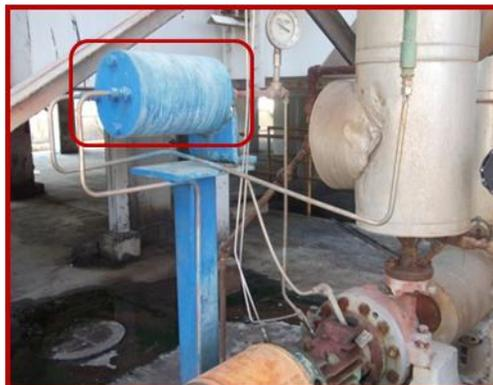
**En el plan API 32 para inyección de fuente externa de líquido y el plan API 62 para lavado con fluido externo (vapor, agua, etc.) del sello, se encontraron manómetros en mal estado. Adicionalmente, se observa mala instalación de los planes por uso excesivo de codos y accesorios. Ver figura 10. En los lineamientos**
