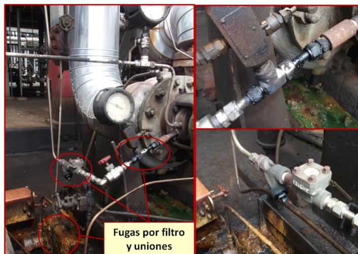
Tenemos planes API 62 sin la instrumentación adecuada en la instalación. No tienen manómetros y no cuentan con facilidades para la instalación de los mismos. Ver figura 12. La configuración del plan 62 según API requiere un manómetro para monitoreo de la presión de entrada del fluido de lavado al sello. <sup>[3]</sup>
