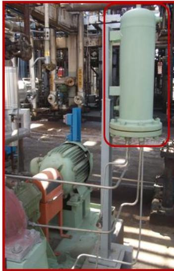
Se usan Intercambiadores fuera de especificaciones, como el mostrado en la figura 9. Según especificaciones API 682, se debe usar intercambiador API 682 modelo LHXR-0682-SCS (Ver anexo B). <sup>[3]</sup>
