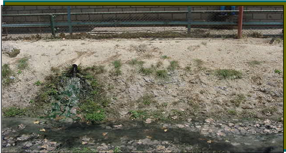
Figura 11. Punto de vertimiento del sistema de tratamiento No. 3
