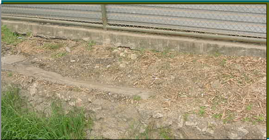
Figura 13. Campo de infiltración del sistema de tratamiento No. 4
