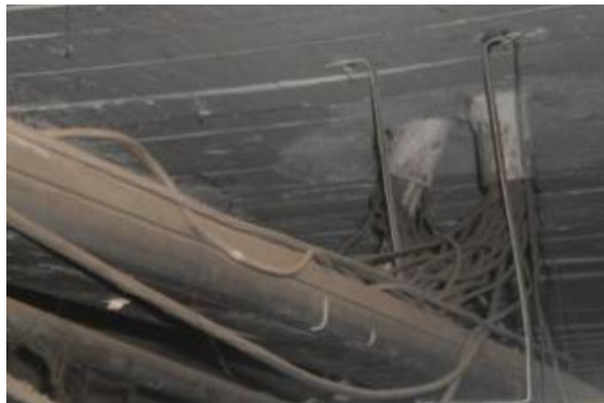
Figura 6. Tuberías PVC que bajan del Dpto. Sistemas
