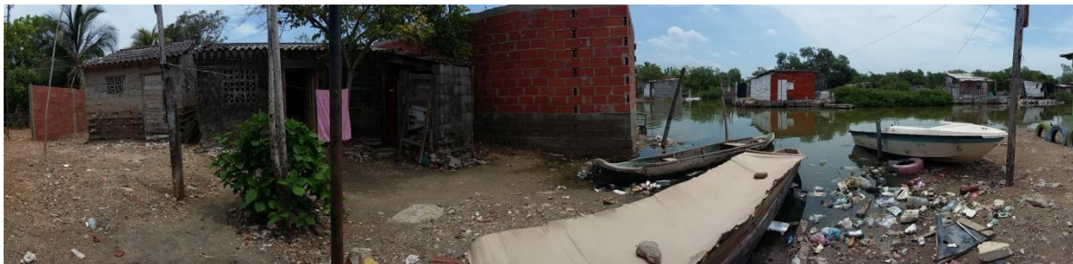
Estado actual muelle. Fuente propia
