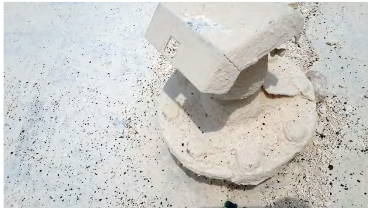
Figura 4. SIEMENS SITRANS LR560 MONTAJE EN CAMPO DEL INSTRUMENTO
