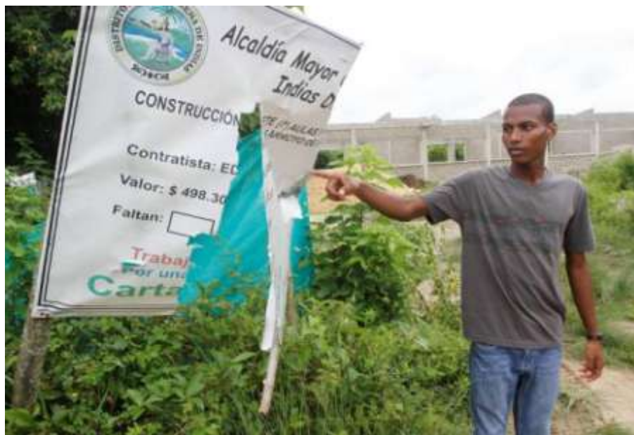
Figura 5. Fotografía de obras de la escuela paralizadas en el 2012. Fuente. El universal 2012 (Julio Castaño)
