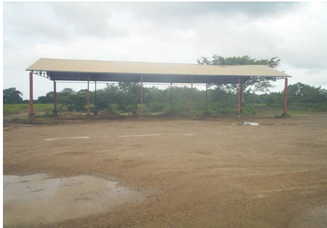
Figura 10. Bodega para almacenar materiales
