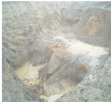
Figura 6. Cortes en arena limpia
