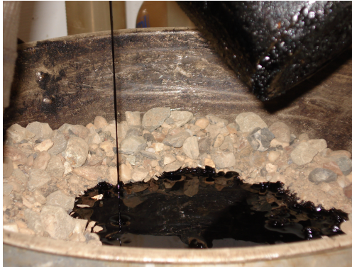
Figura 23. Dosificación del asfalto en mezcla.
