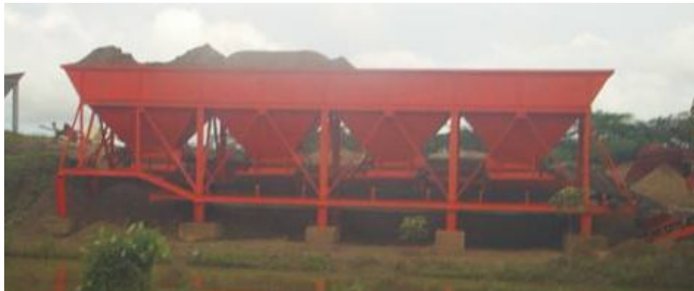
Figura 15. Tolvas de agregados en frío.
