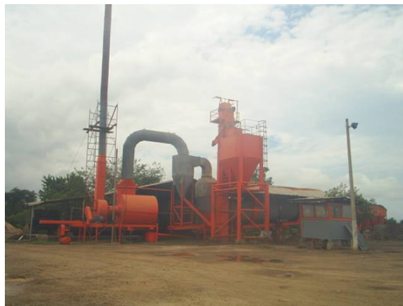
Figura 14. Planta de asfalto Torcoroma
