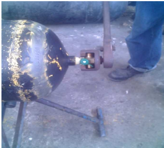
Figura 3.24 Instalación de Válvula de Cilindro
