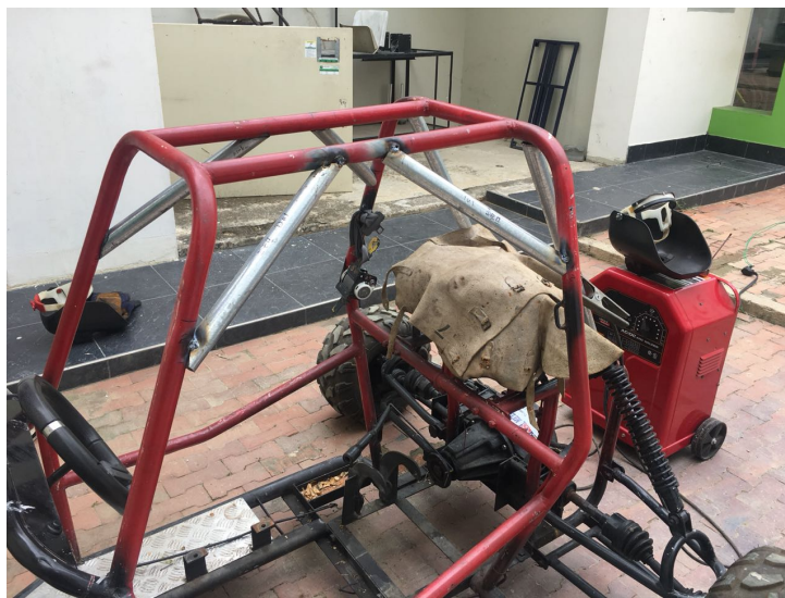
Figura 148: Soldadura lateral del chasis
