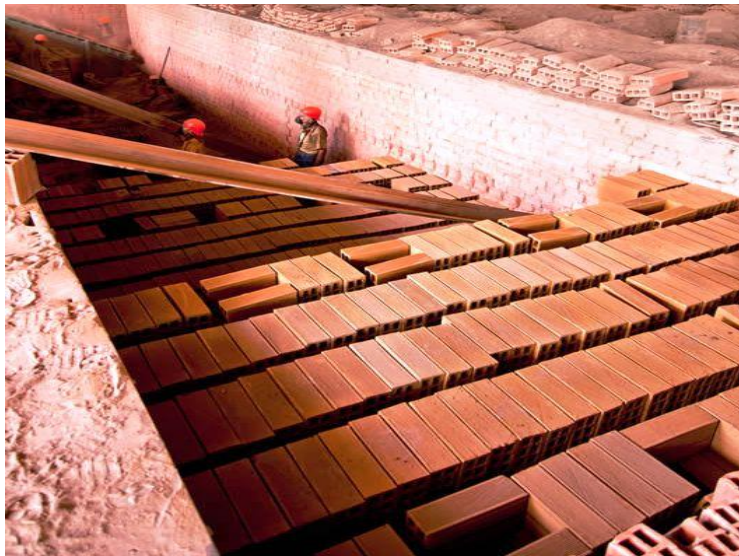
Imagen 5. Interior de los hornos utilizados en la ladrillera La Clay S.A.
