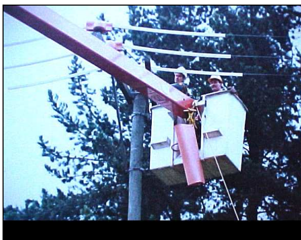
Figura 10 Cubrimiento de estructura para TET
