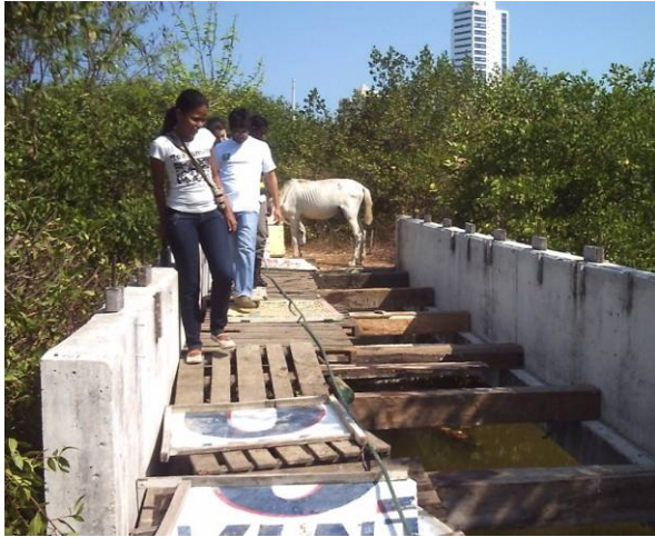
Puente de ingreso
