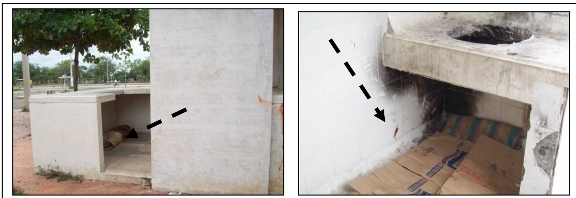
Figura 27. Casetas de baños exteriores
