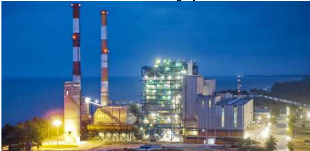
Figura 1. Vista nocturna de la Planta Termoguajira.
