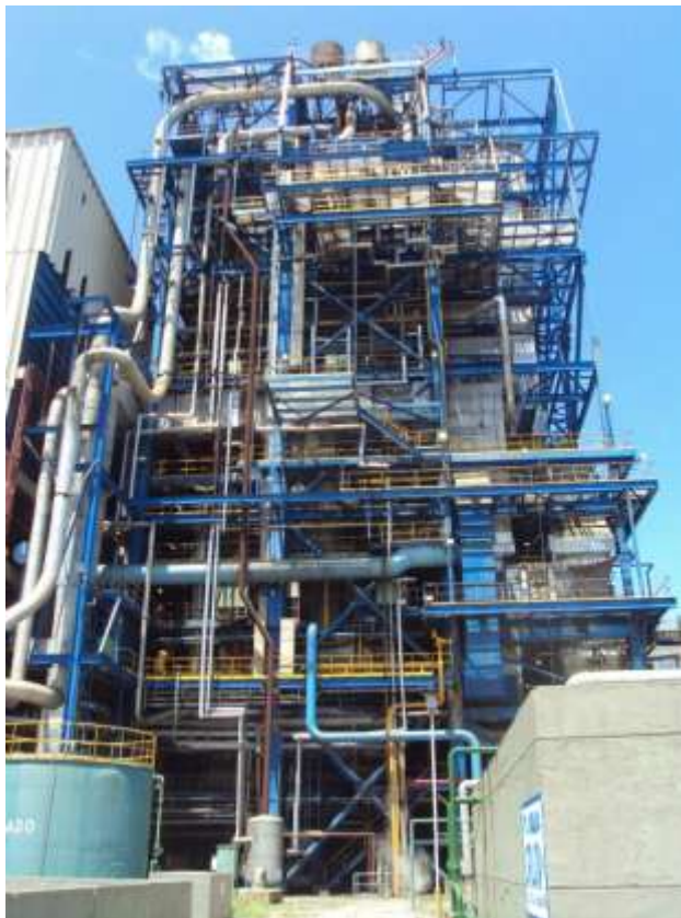
Figura 2. Vista exterior de la Caldera Unidad 1.
