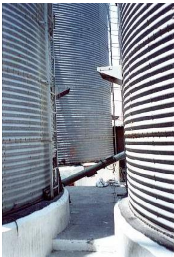
Foto de los silos de almacenamiento
