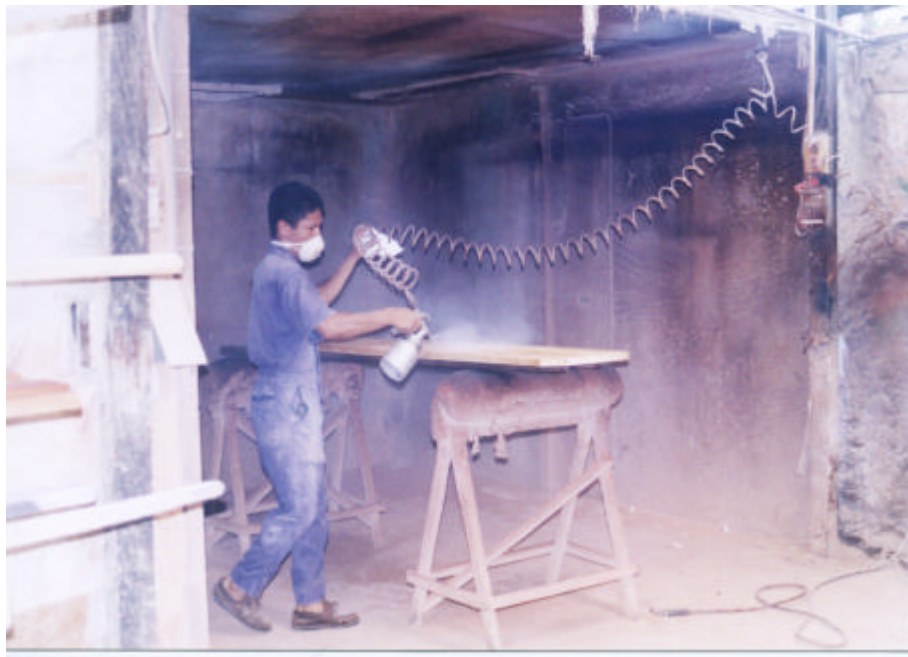
Figura 19. Área de Pintura
