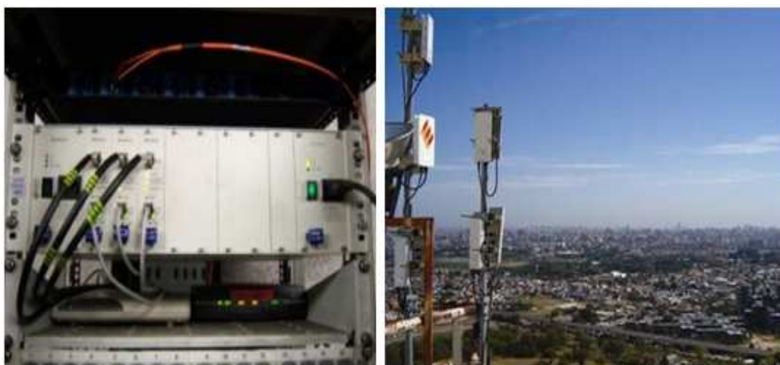
FIGURA 7. Estación Wimax y campo de cobertura.
