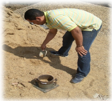
Foto 14: Primera capa de agregado.
