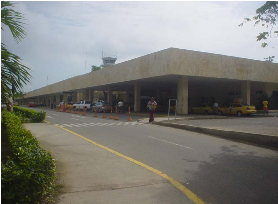
Fachada Aeropuerto Internacional Rafael Núñez. Barrio de Crespo.
