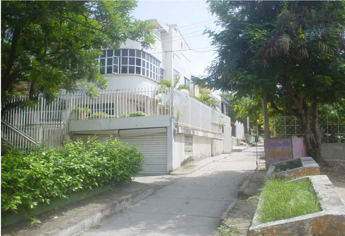
Fachada casa de Lucho. Campestre 1 etapa manzana 9 lote 18
