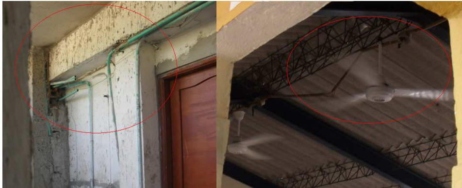
a) Pasillo edificio administrativo.
