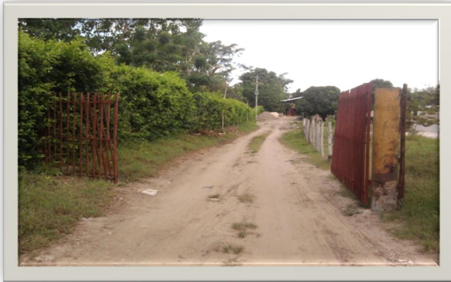
Adquisición de Terreno en 2009. Construcción Planta de beneficio El Mango.
