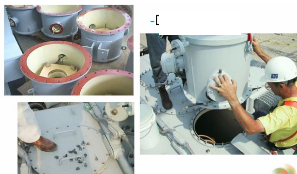
Figura 26. Montaje de Domos.
