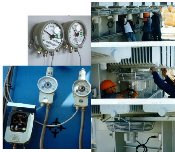
Figura 30. Montaje de Ventiladores y accesorios.
