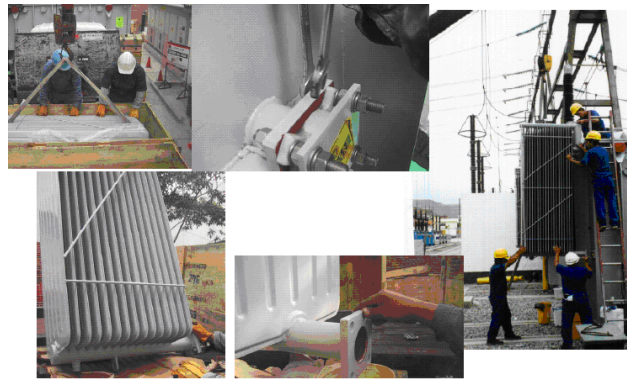
Figura 25. Montaje de Radiadores.
