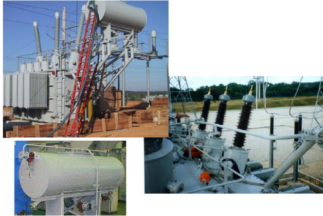
Figura 28. Montaje Tanque de expansión y tuberías.
