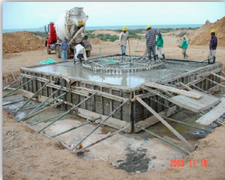
Figura 7. Vertimiento de la Mezcla de la Base 56
