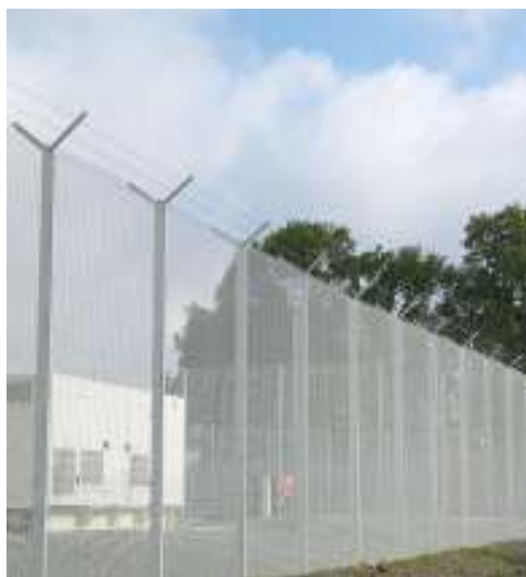
Figura 1. Mallas de Seguridad
