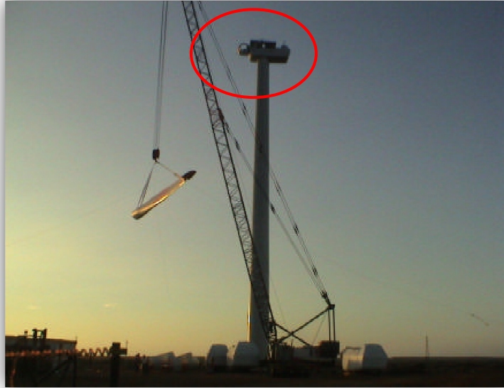
Figura 13. Montaje de Góndola en la Torre 61
