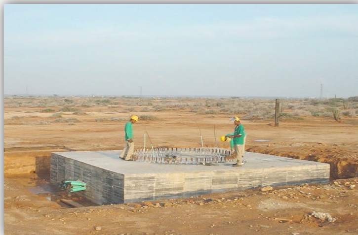
Figura 8. Inspección de la Base de la Torre 57
