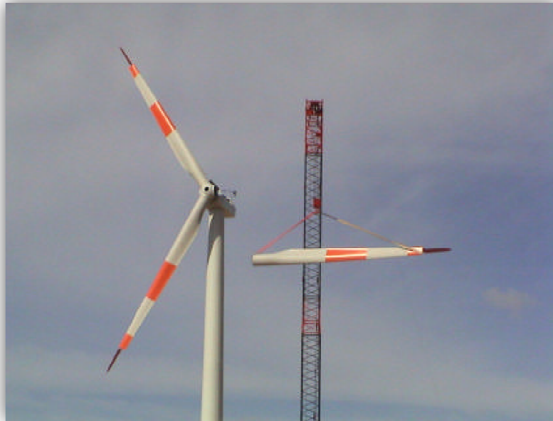
Figura 14. Montaje del Rotor, Aspa por Aspa 62
