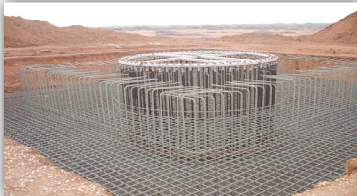
Figura 6. Armado de la base de la torre 55
