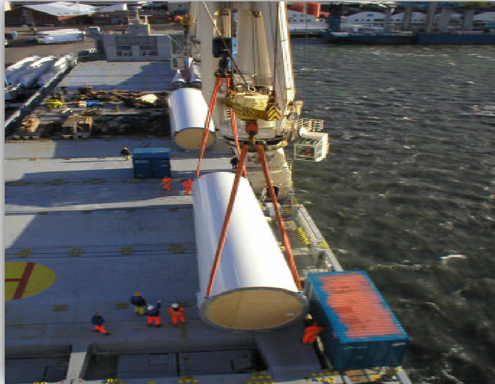
Figura 3. Transporte de la Torre en secciones 51 .
