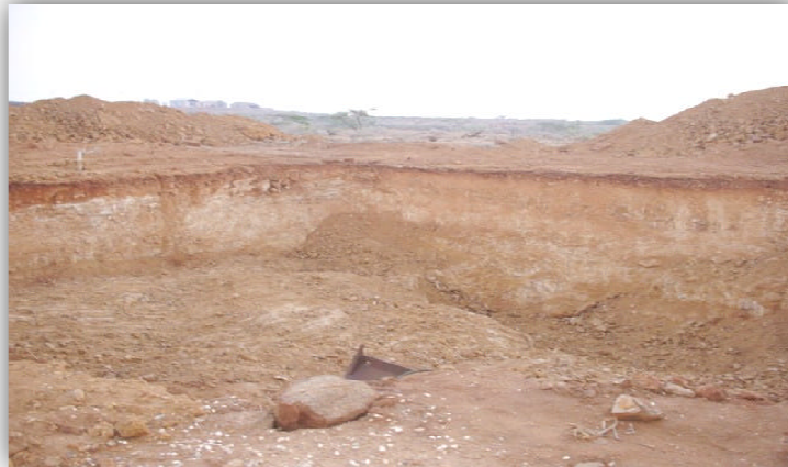
Figura 5. Base excavada para el aerogenerador 54
