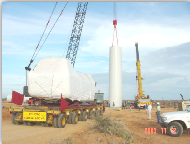
Figura 9. Posicionamiento de Partes de la Torre 58
