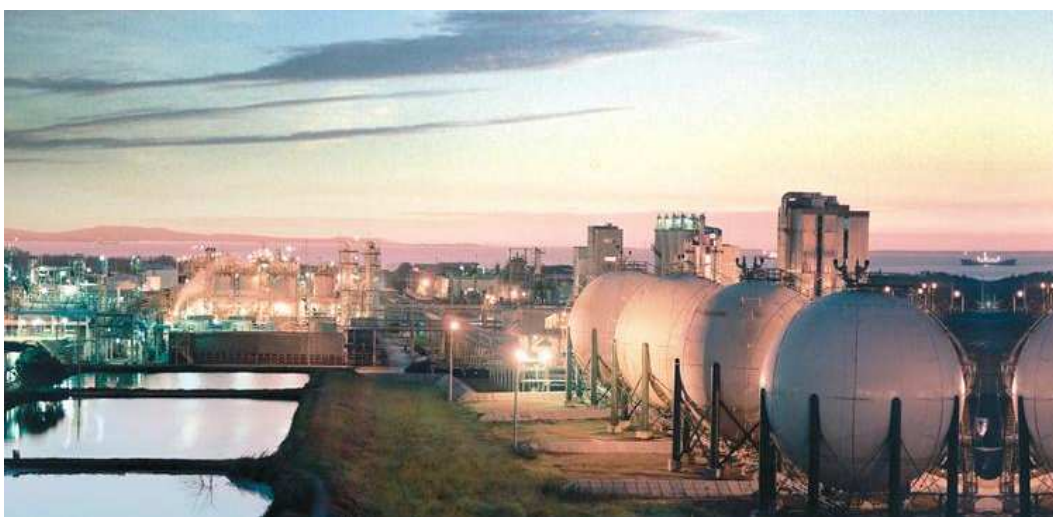
Figura 1. Planta de Mexichem Resinas de Colombia
