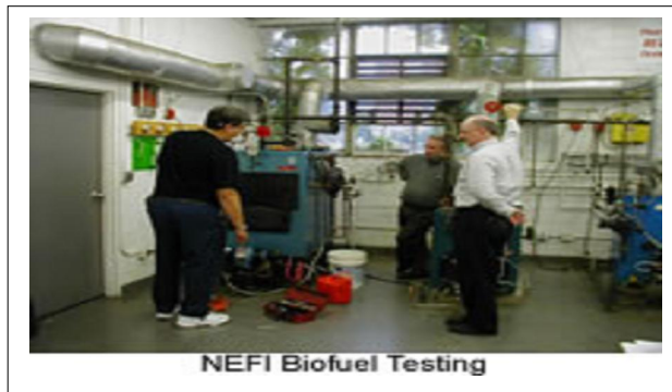
Figura 3. Maquinas de calefacción de biodiesel
