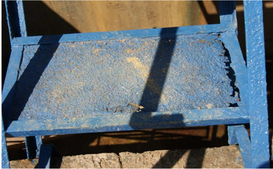
Foto 38. Escalera de acceso a tanques
