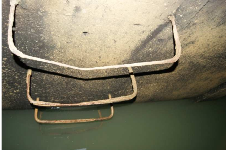
Foto 40. Escalera de acceso a tanques de almacenamiento
