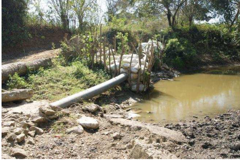
Foto 13. Tubería de Aducción que atraviesa arroyo.
