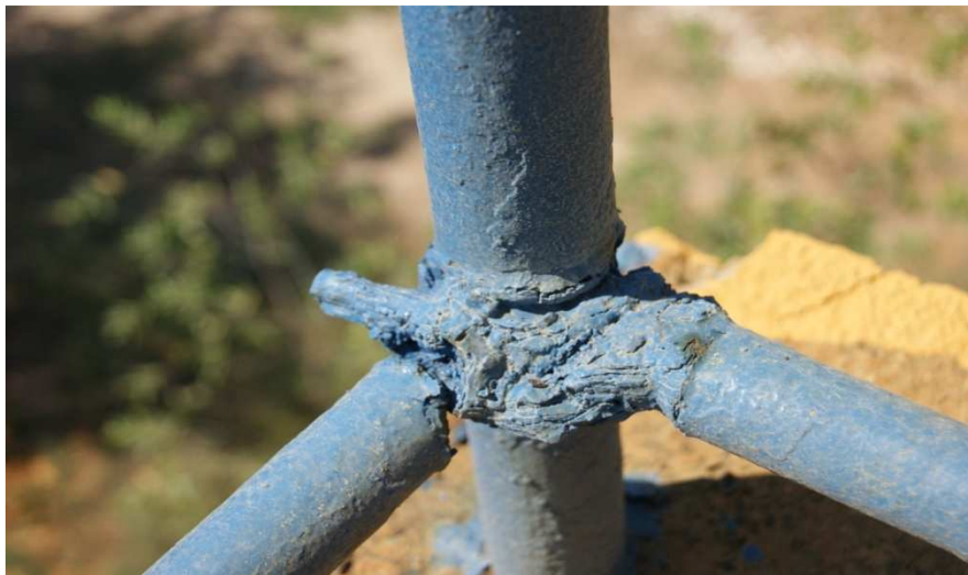
Foto 37. Nodo de uniones soldadas de barandas de seguridad
