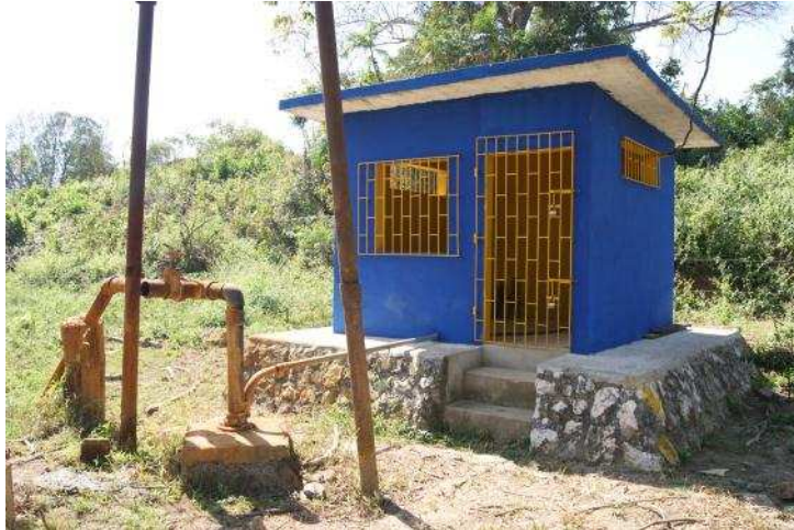
Foto 6. Pozo No. 2 En servicio.
