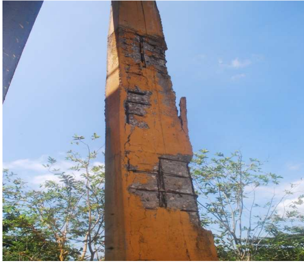
Foto 48. Perdida de las propiedades físicas del concreto
