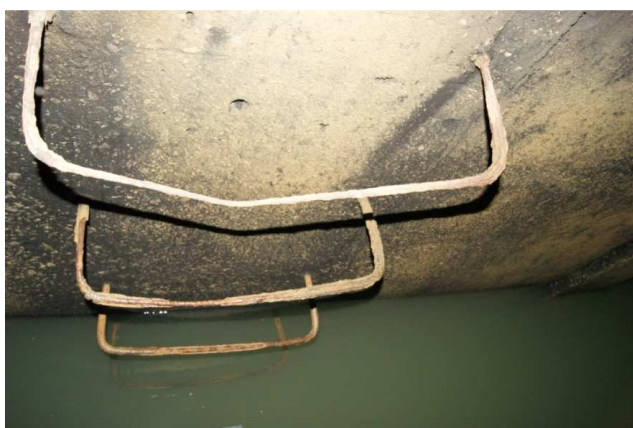
Foto 51. Escalera de acceso a tanques de almacenamiento
