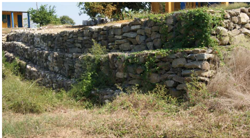
Foto 49. Obras de refuerzo sobre el suelo alrededor de la planta de tratamiento
