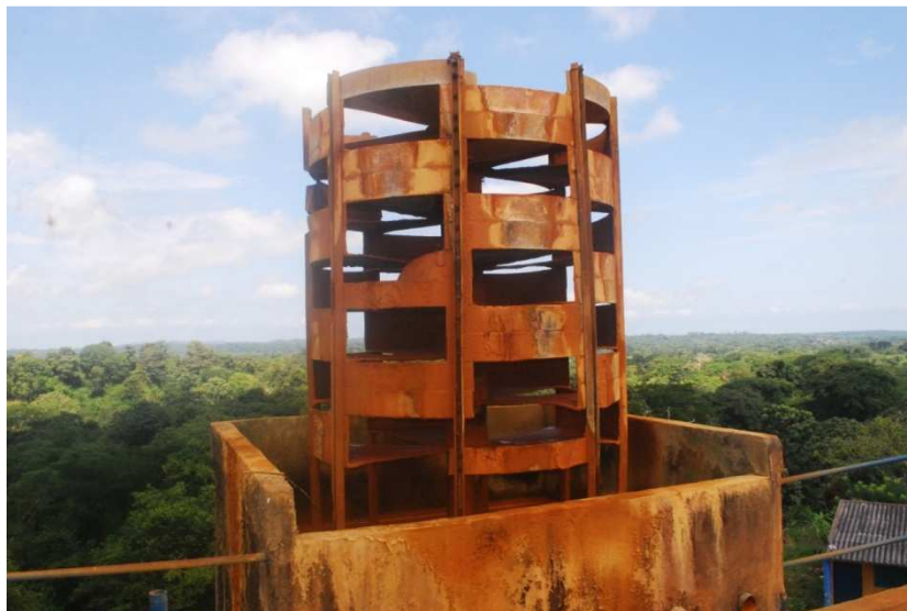
Foto 2. Torre de aireación en fibra de vidrio Fuente: Autor
