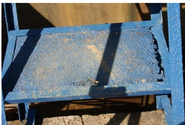
Foto 52. Escaleras de Acceso a tanques de proceso
