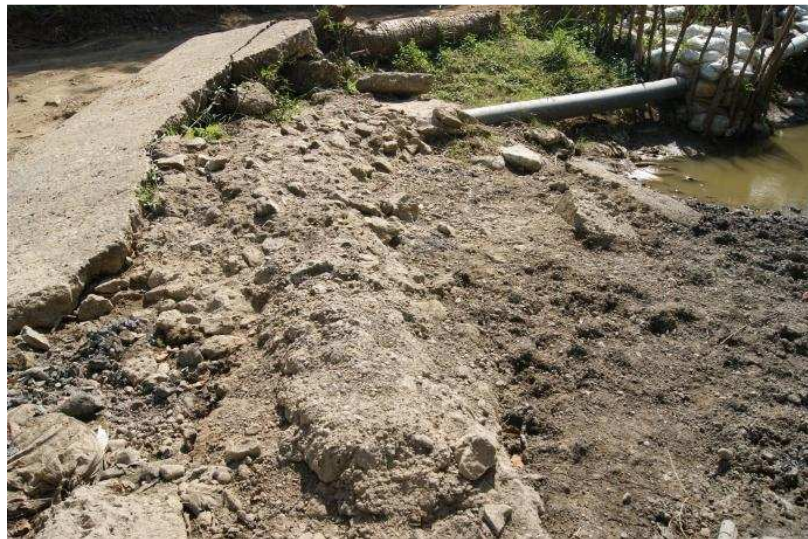
Foto 16. Obra de anclaje de tubería
