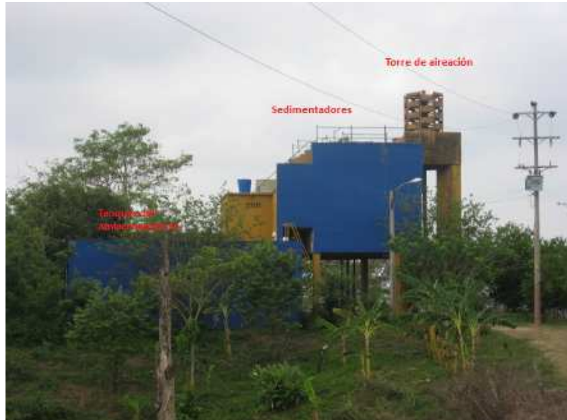
Foto 17. Planta de Tratamiento de agua Potable
