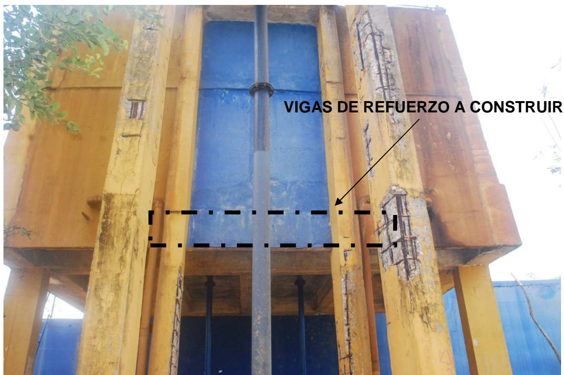
Figura 45. Refuerzo estructural recomendado
