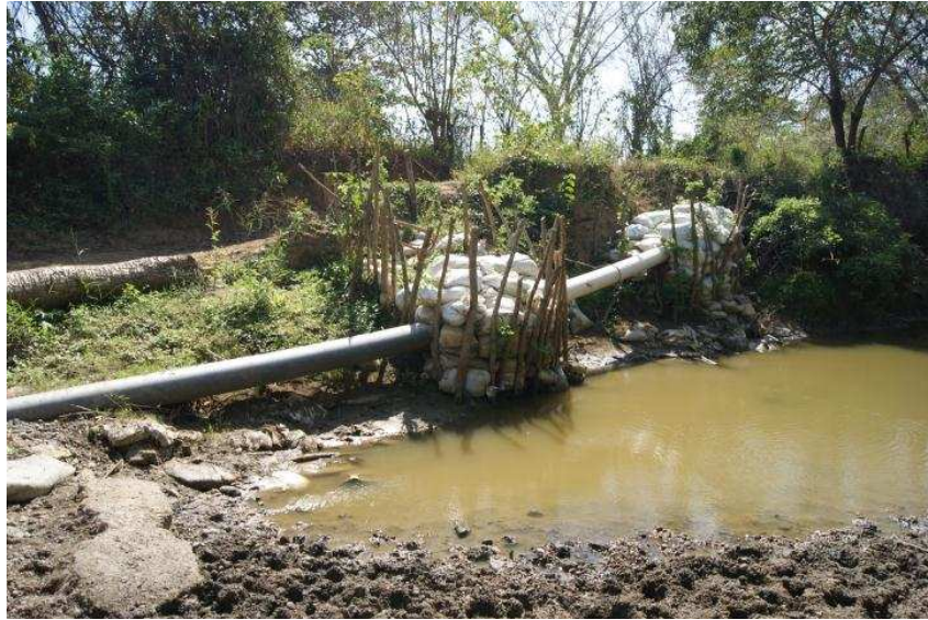
Foto 15. Obras de anclaje de tubería para el invierno.
