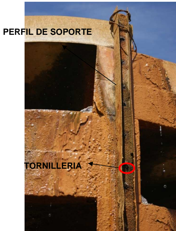
Foto 55. Perfil de soporte torre de aireación Fuente: Autor
