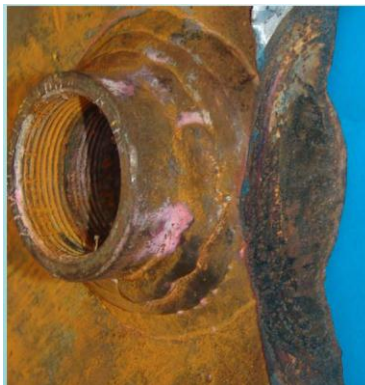
Fig. 13 Falla por fatiga
