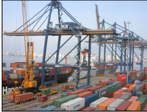
Imagen 7. Vista panorámica del Sitio 8 y Sitio 9 y grúas pórtico.
