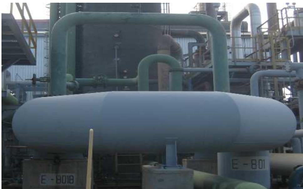
Figura 4.2.8. Coolers condensers (Condensadores de superficie)
