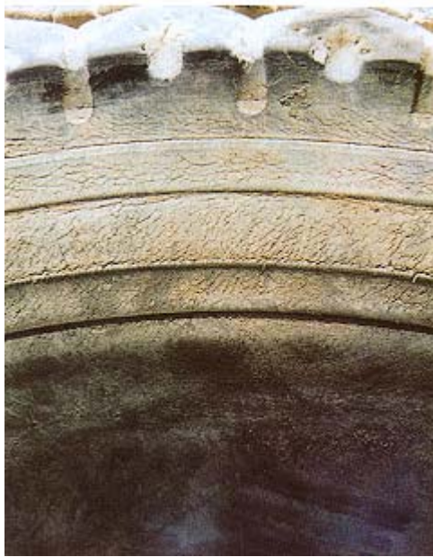
Ilustración 44 Neumático con grietas
